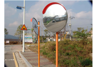
(예시) 거리 반사경 설치
