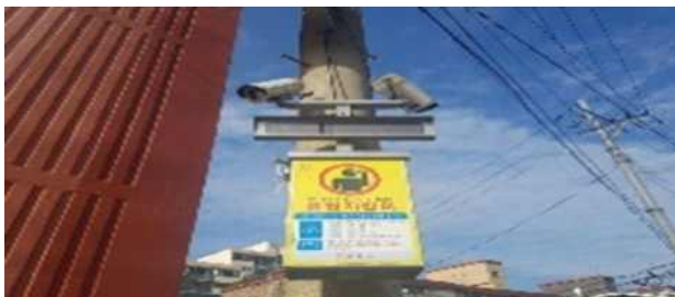
① 오동나무1길 7 CCTV
