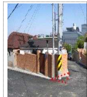
진입도로 정비 후
